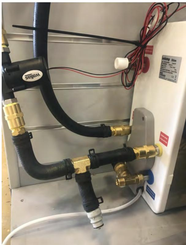
2) Schließen Sie die Kühlmittelpumpe an das freie Ende des T-Stücks an und sperren Sie mit einer Schlauchzange eine Leitung ab.
